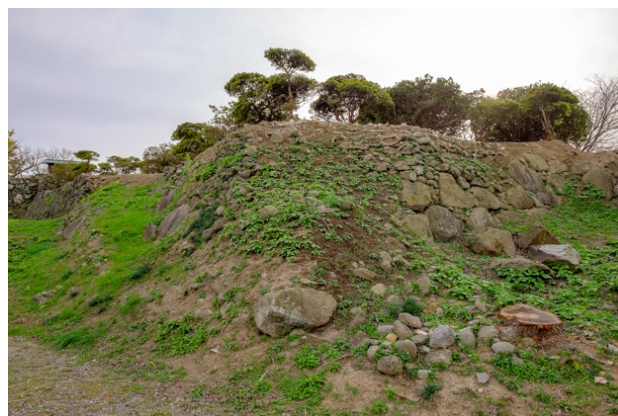
原城の城壁跡
