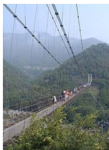
谷瀬の吊り橋
